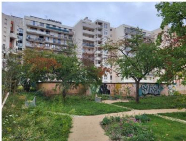
Vue du mur
