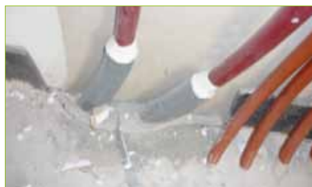
1) Adhésif d'étanchéité 2) Etanchéité sur un fourreau
