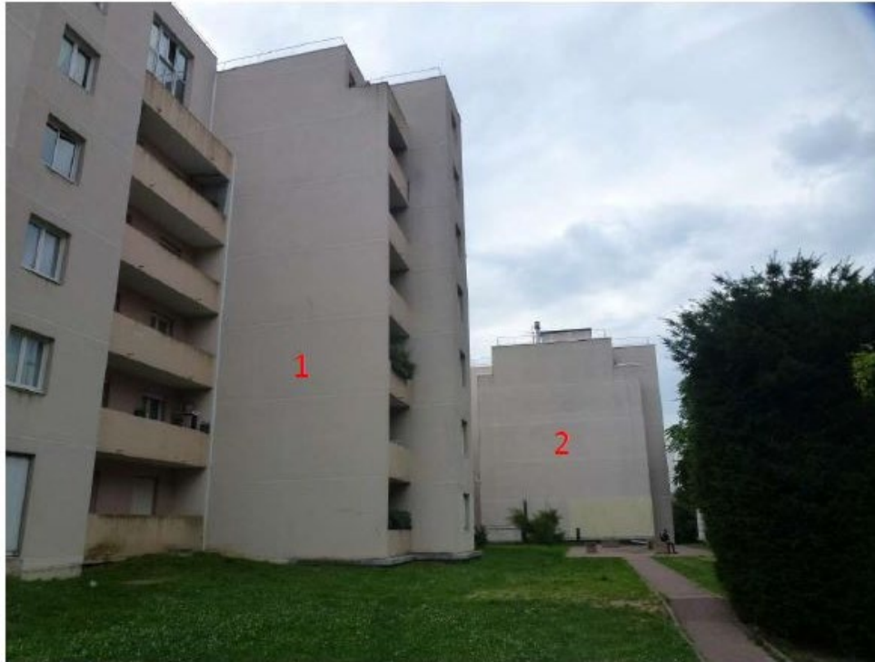
13 et 11 Route Stratégique / arrière des immeubles côté jardin Visible depuis les espaces verts Jean Moulin, mais pas depuis la voirie
