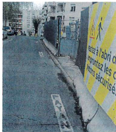
Travaux RATP - Rue Edouard Vaillant
