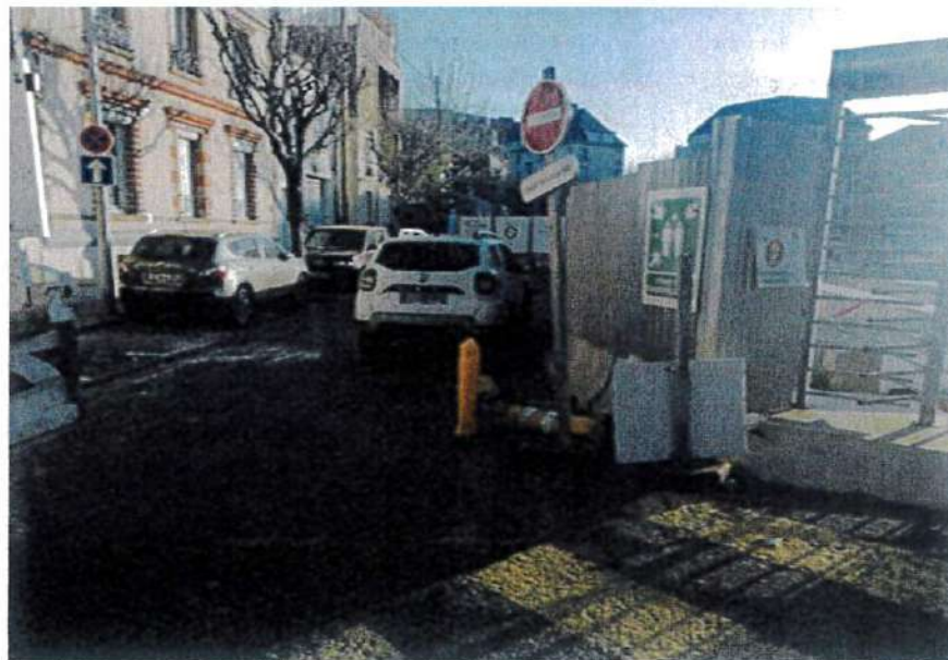
Travaux RATP - Square Jules Guesde - Tronçon 1
