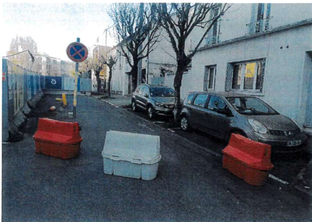
Travaux RATP - Square Jules Guesde - Tronçon 2.1
