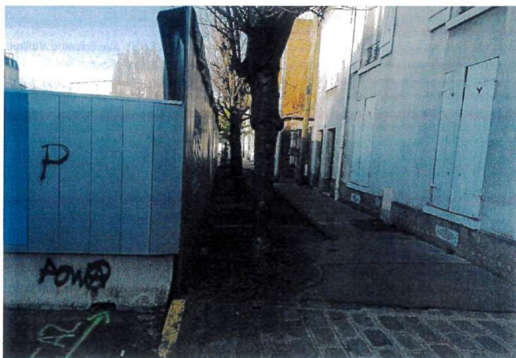
Travaux RATP - Square Jules Guesde - Tronçon 2.2
