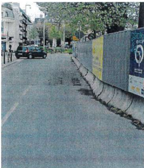
Travaux RATP - Avenue du Dr Antoine Lacroix
